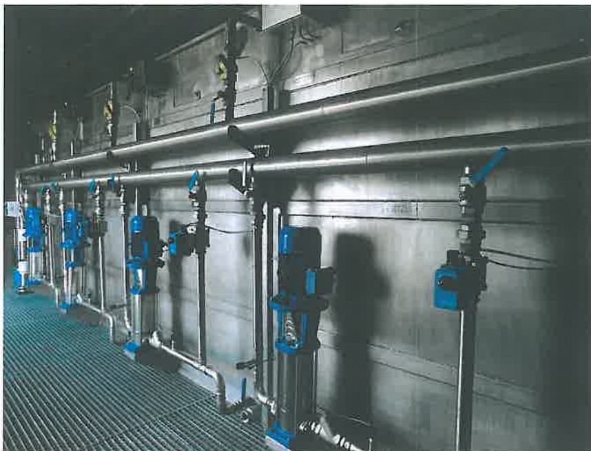
System sterownia pracą filtrów
