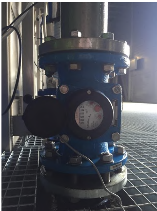
Wodomierz wody uzdatnionej - pomiar
