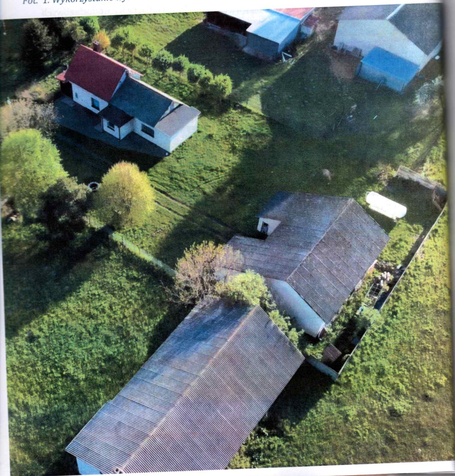
Fot. 1. Wykorzystanie wyrobów azbestowych jako pokrycia dachowe.
